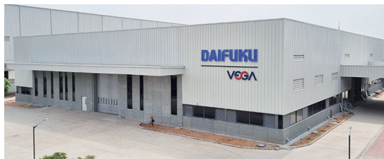
現在稼働中の工場
