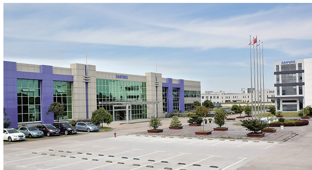
大福(中国)物流設備有限公司の新社兼工場
