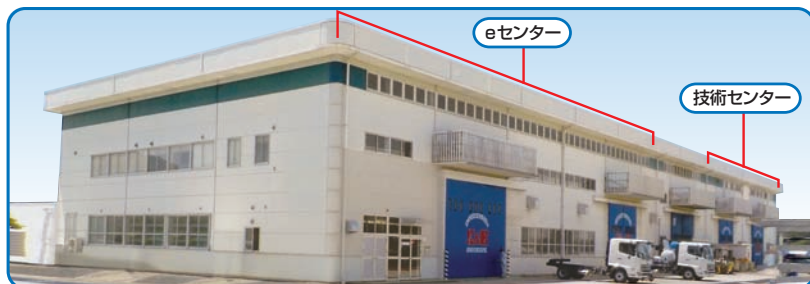
[eセンター&技術センター]
