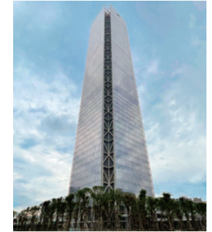
富邦(ふほう)ファイナンシャルホールディングス本社ビル 新設・受注 台湾の大手保険会社「富邦生命」の本社ビル。 エレベータ29台・エスカレータ4台を受注。うち16台は一度に多くの人を輸送できる2階建ての「ダブルデッキエレベータ」を採用。
