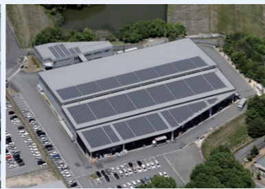
岡山第二工場
