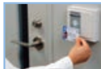
入退室管理システム
