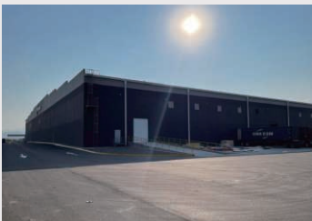
建設中の工場建屋
