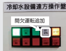
冷却水設備 遠方操作盤
