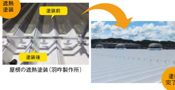
屋根の遮熱塗装(羽咋製作所)
