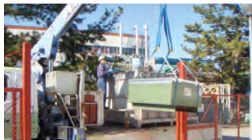
PCB含有コンデンサの搬出の様子
