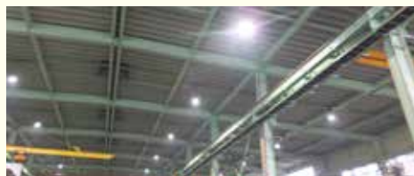
水銀灯からLEDへ変更(羽咋製作所)
