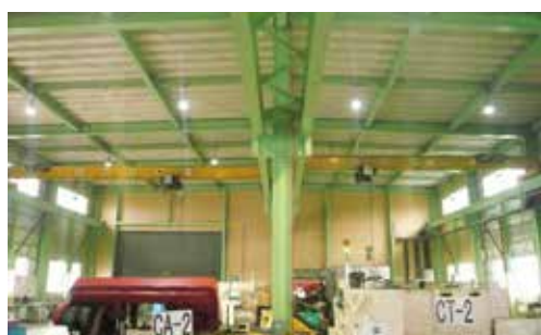
照明を水銀灯からLED化(志賀製作所)
