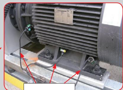
振動センサを組込み、軸受け、パッキン等の摩耗を監視します。
