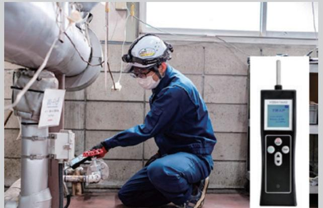
スチームトラップチェッカー『STC-1』を用いた当社エンジニアによる工場診断の様子
