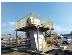
ユニット型チェン式自動除塵機
