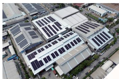
キッツグループのタイの生産拠点で青銅・黄銅製バルブ及びバタフライバルブの製造を担うKITZ (Thailand) Ltd.は、環境に関する取り組み「3ZERO(トリプルゼロ)」のCO<sub>2</sub>ゼロを達成するために太陽光発電システムを増設し、2022年9月に稼働を開始しました。環境負荷低減に寄与するため、2016年にメイン工場であるBangplee(バンプリ)工場に太陽光パネルを導入しましたが、このたび2,112枚を増設し、総パネル数3,612枚となりました。太陽光パネルによる発電量は、バンプリ工場における2021年の月平均使用電力量の10.3%に相当します。
