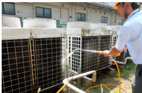
空調熱交換機の洗浄
