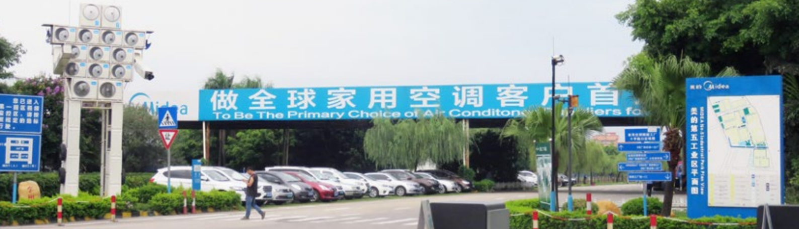
美的集团家庭用エアコン工場
