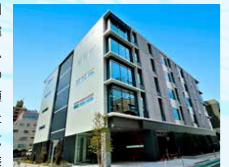
EVマルチPCSシステムを設置したグループ会社のビル (東京 五反田、明興ビル)
