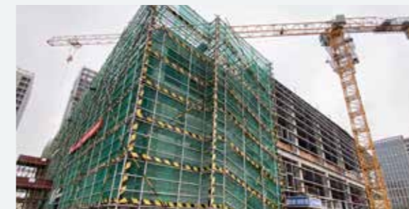
建設工事中のEV工場第2ライン
