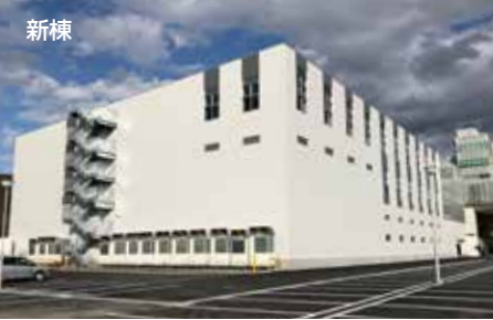
「振動試験室」、「高速運転試験室」、「環境試験室」も設置。
