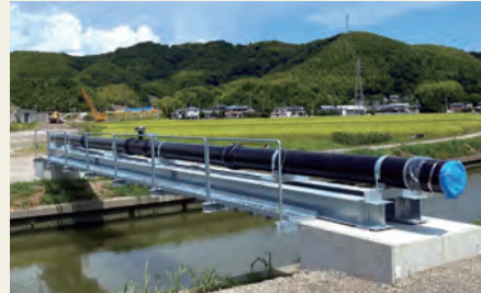
水管橋の整備状況
