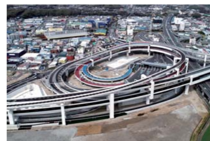
横浜港北JCT 写真提供：首都高速道路株式会社
