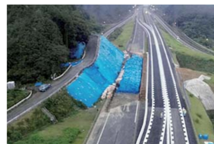
長崎自動車道 武雄JCT付近応急復旧状況 写真提供：西日本高速道路(株)
