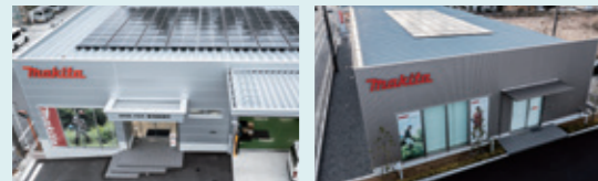
鹿兒島営業所の太陽光パネル 茂原営業所の太陽光パネル
