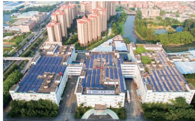
道ジャオマブチ屋上の太陽光発電パネル
