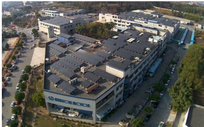
東莞マブチ屋上の太陽光発電パネル
