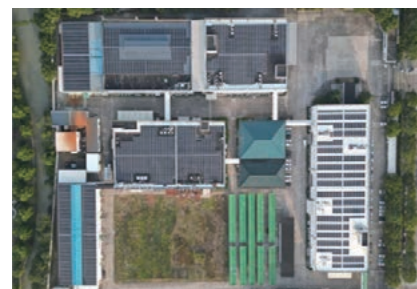
ニデックプレジジョン(浙江)に導入した太陽光発電システム
