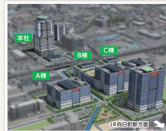
新拠点の完成イメージ図。京都市南区の本社ビルとJR向日駅（向日市）間の同駅東側に立地。
