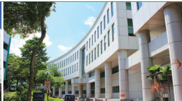
シンガポールモーター基礎技術研究所
