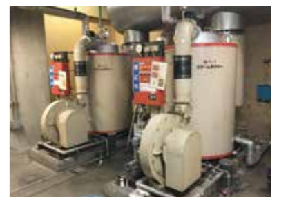
廃止前の化石燃料使用ボイラー(JVCケンウッド長野)
