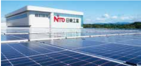
太陽光発電設備（菊川工場 物流倉庫屋根）
