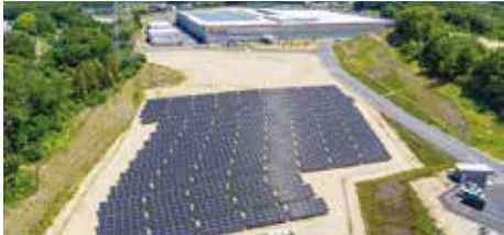
太陽光発電設備（瀬戸工場 1,134kW）
