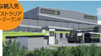
2 ウールワースディストリビューションセンター 国内最大のスーパーマーケットチェーンウールワースの配送センター。IXシステムを採用。
