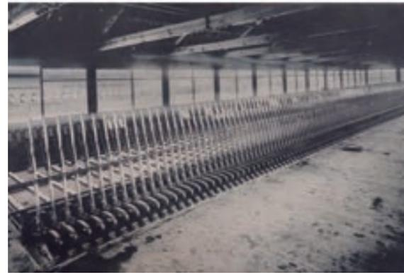
1906年に公布された鉄道国有法により全国主要幹線が国有化され、輸送需要が急増。鉄道信号の近代化と国産化要求の使命を担い、3社合併により、1928年12月日本信号株式会社設立。(写真は1914年、京都停車場に納入した機械式連動装置。三村工場絵葉書より：鉄道博物館所蔵)
