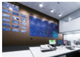
交通管制センター
