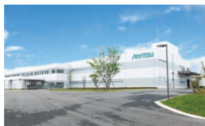
東北アンリツ第二工場(郡山市)
