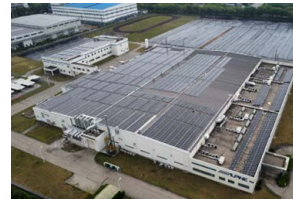
アルパイン太倉の太陽光発電設備
