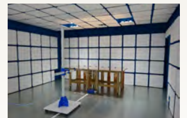
ヒロセ電機本社 EMC試験用電波暗室
