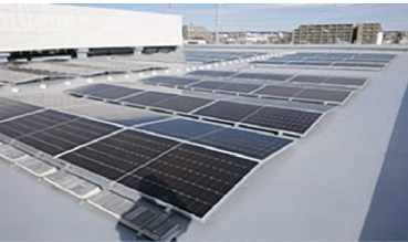
太陽光パネル設置状況
