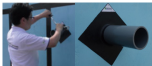
気密部材の施工事例
