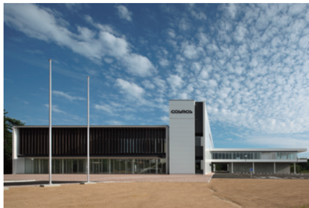
▶ 写真 センサ工場外観
