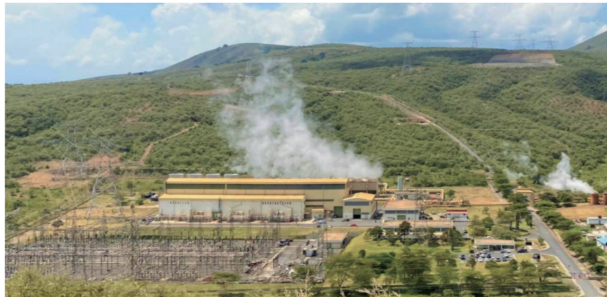
オルカリア地熱発電所 II
