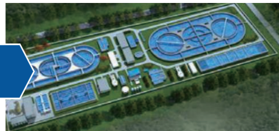
下水処理場の省エネルギー
