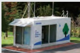
大気汚染監視用分析装置 (汚染物質の計測)
