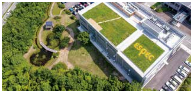
エスペックミック施工の屋上緑地
