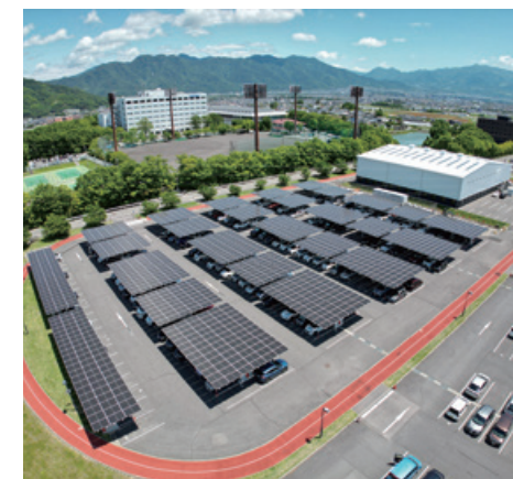
ソーラーカーポート第一期工事後
