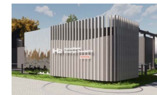
株式会社デンソー福島 水電解装置実証施設
