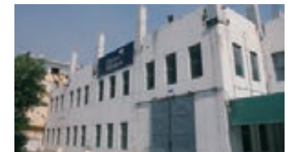
改築中のElectropolymers (Private) Limited本社工場
