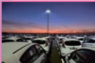
ベルギーの港湾に 設置されたLED照明
