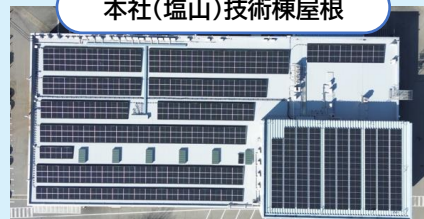
本社(塩山)技術棟屋根
