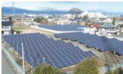
当社は、保有資産の有効活用と環境への配慮を目的として、群馬県のKIBANセンター工場に隣接する駐車場跡地に太陽光発電設備を設置いたしました。発電容量が180kWとなる720枚の太陽光パネルを取り付け、本年4月から発電を開始しております。小規模ながら売電による利益貢献に加え、CO<sub>2</sub>の削減にもつながります。
