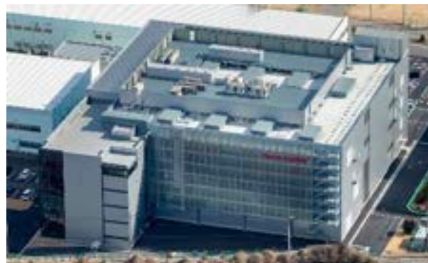
八幡原工場材料棟(群馬県高崎市)
