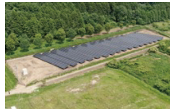
V-PPAにおける太陽光発電設備設置の様子
