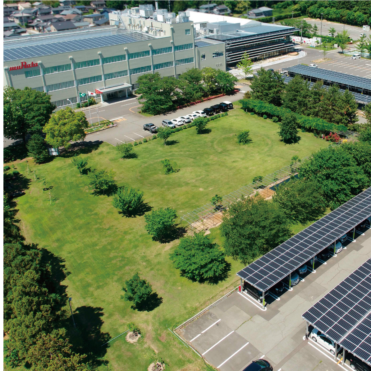
金津村田製作所(福井県)は2021年に独自の制御技術を活用した再エネシステムを導入し、ムラタ初の再エネ利用100%を達成しました。ムラタは再エネ100%調達の実現に向け、グループ全体の事業活動における使用電力の再エネ化を推進するとともに、地域社会の環境負荷低減に貢献することで持続可能な社会の実現を目指します。
