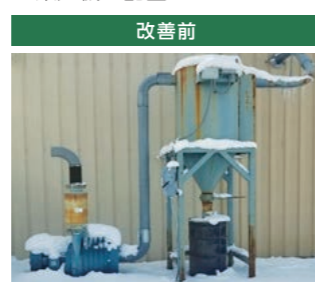
大型集塵機によりフロア全体の材料の破片を回収
