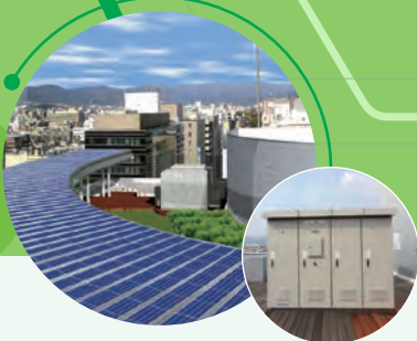
公共・産業用 蓄電システム
