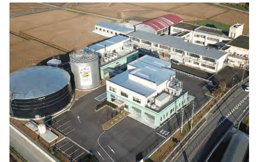
みやま市バイオマスセンター
