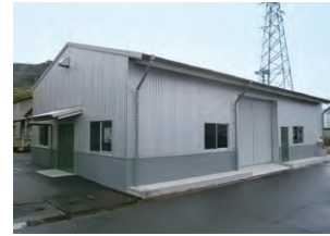
三井E&S玉野事業場に新設した実習棟
