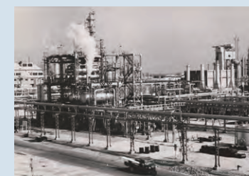
1958年 三井石油化学工業(株) 岩国工場向けNo.1エチレンプラント
