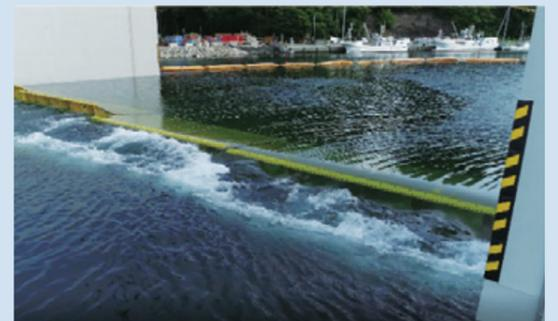
岩手県向け海底設置型フラップゲート式水門(ゲート浮上の様子:港外側より)
